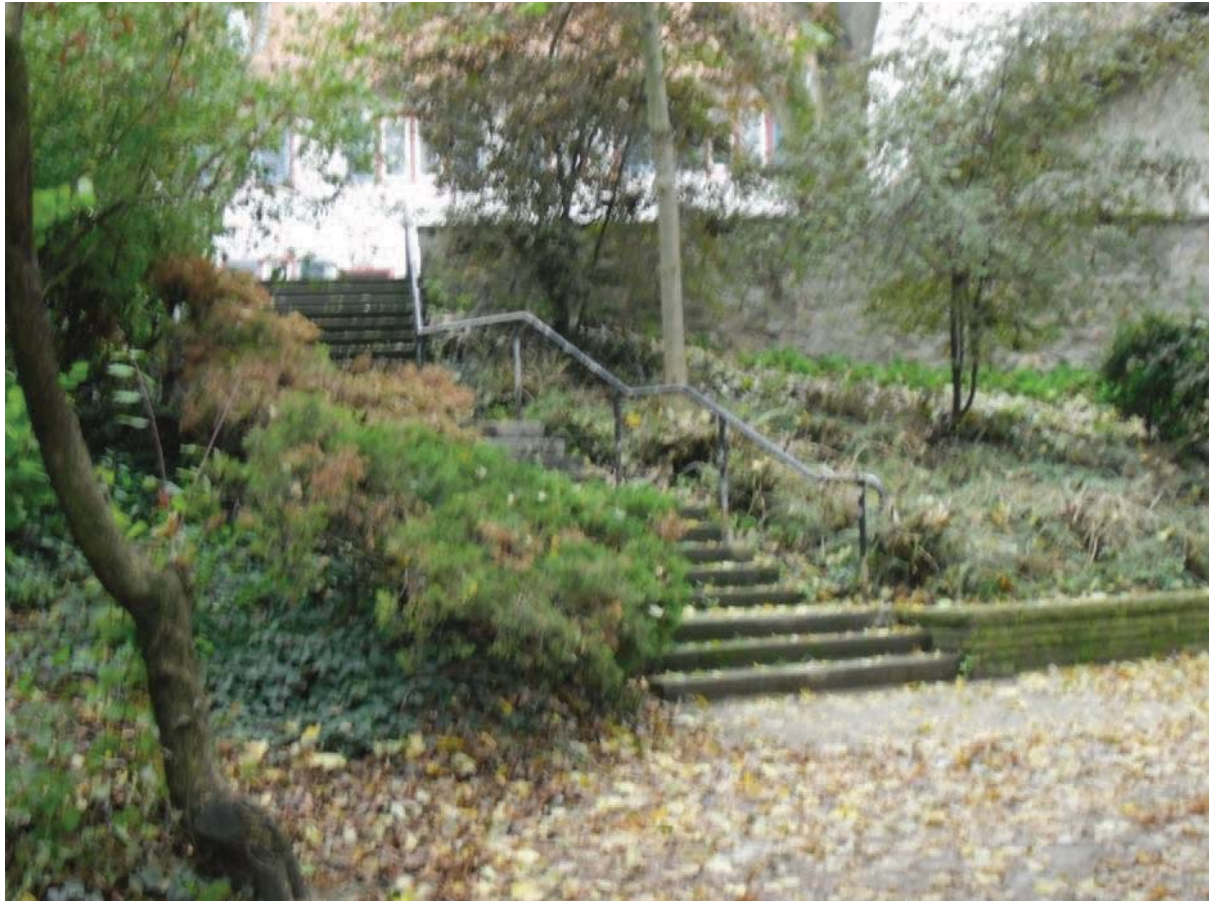
Schlecht beleuchtete Treppenanlage (Zugang zur Remise) im Stadtpark (Quelle: Eigenes Foto)
